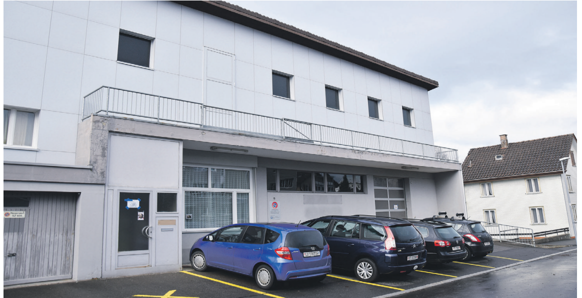
Auch ein Ort, an dem das Welttheater entsteht: Die Produktion hat sich in der ehemaligen Wasserversorgung an der Nordstrasse eingemietet. Hier werden verschiedene Chargen wie die Schneiderei arbeiten. Foto: Victor Kälin
